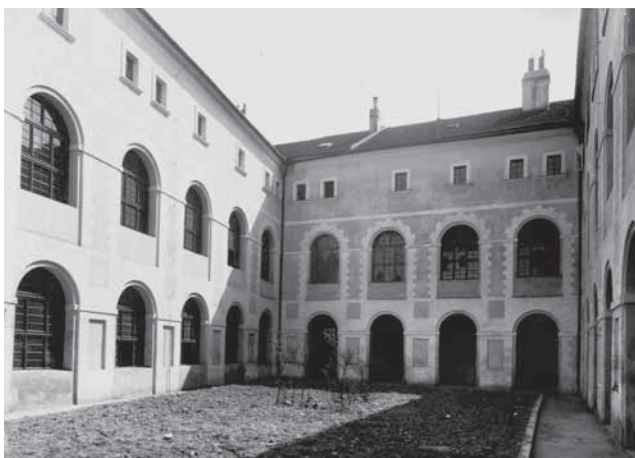
Budova Univerzitnej knižnice na Klariskej ulici 5. Nádvorie kláštora klarisiek (pred rokom 1954)
