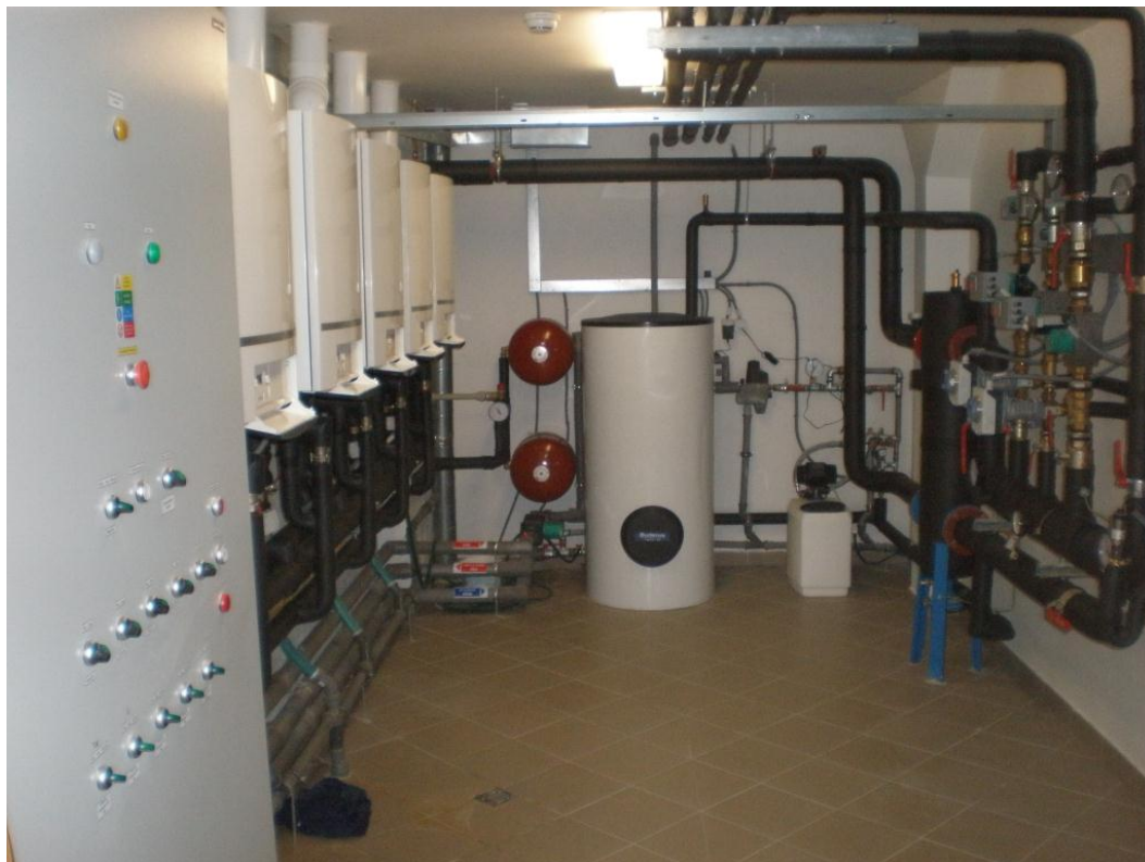
Obrázok 15: Zrekonštruované priestory detašovaného pracoviska SNK vo Vrútkach
