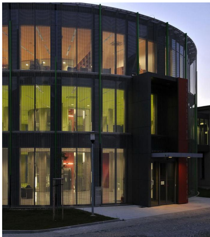
Obrázok 42: Vchod do novostavby Univerzitnej knižnice Univerzity Konštantína Filozofa v Nitre Foto: Juraj Bartoš, ZIPP Bratislava, spol. s r. o
