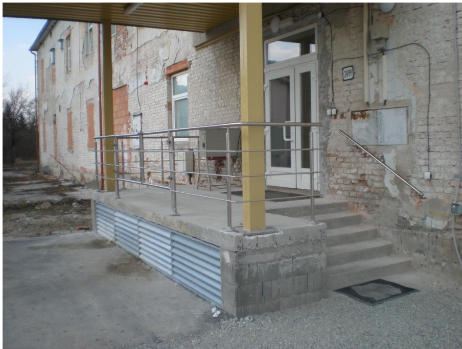
Obrázok 8: Rekonštrukcia budovy detašovaného pracoviska SNK vo Vrútkach
