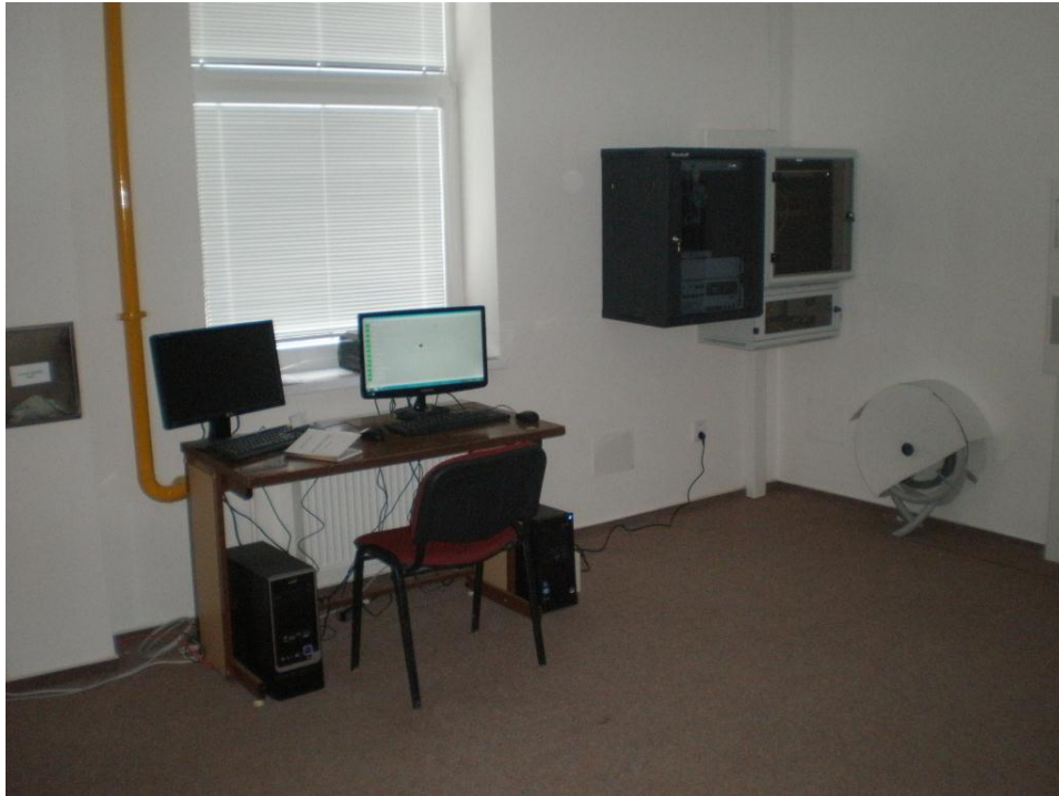
Obrázok 16: Zrekonštruované priestory detašovaného pracoviska SNK vo Vrútkach
